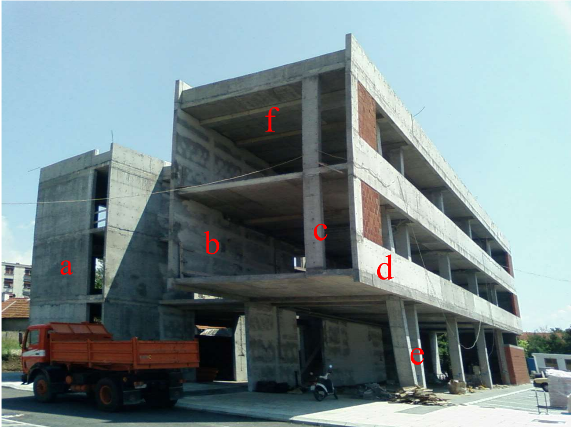
Слика 2. Армиранобетонска конструкција
